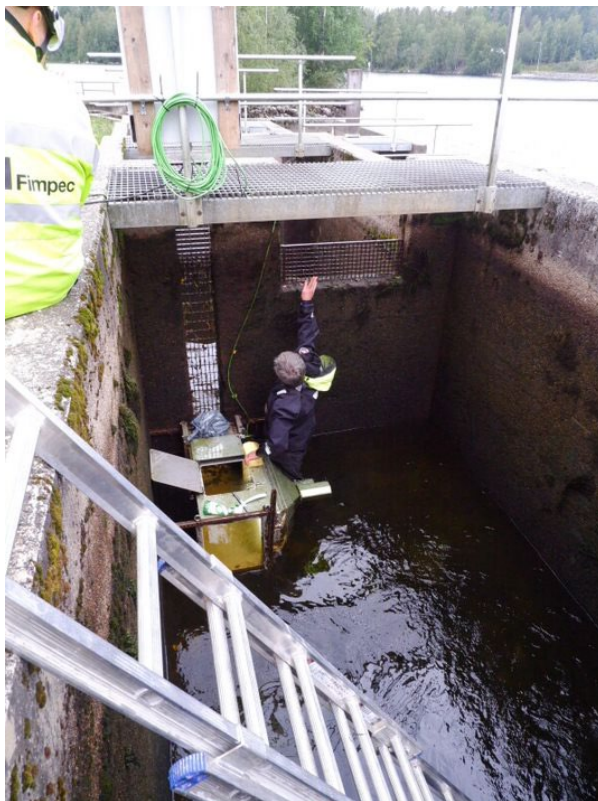
Kuva 1. Kamerayksiköllinen kalalaskuri asennettuna kalatien altaaseen Kuhankosken yläosalla. Kalatien aukon yläosaan asennettiin ritilä ohjaamaan kalat uimaan laskurin läpi.
